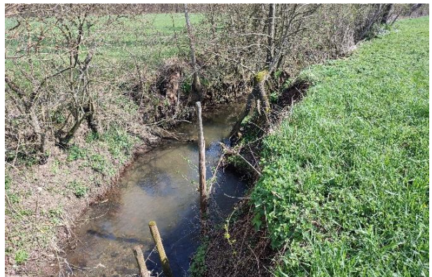
Mit Weidenverbau befestigte Steilufer an der mäandrierenden Schmie unterhalb Lienzingen
