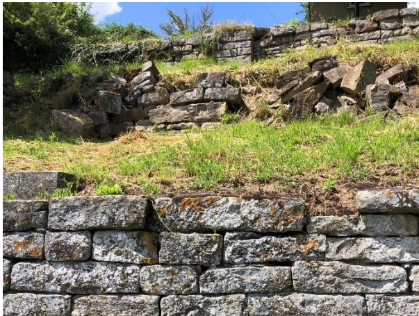
Sanierungsbedürftige Trockenmauerabschnitte an der Enzschlinge
