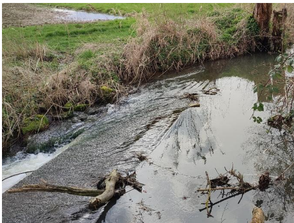
[3] Streichwehr im Erlenbach bei Ötisheim die Durchwanderbarkeit bleibt im Vordergrund
